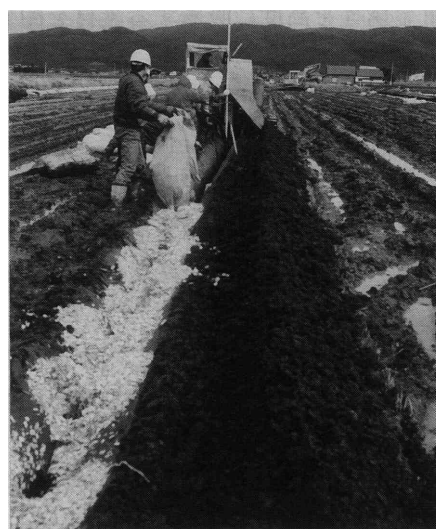
写真1 暗渠工事の様子
