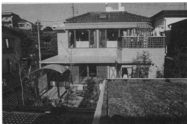
写真31 改修後の南邸
