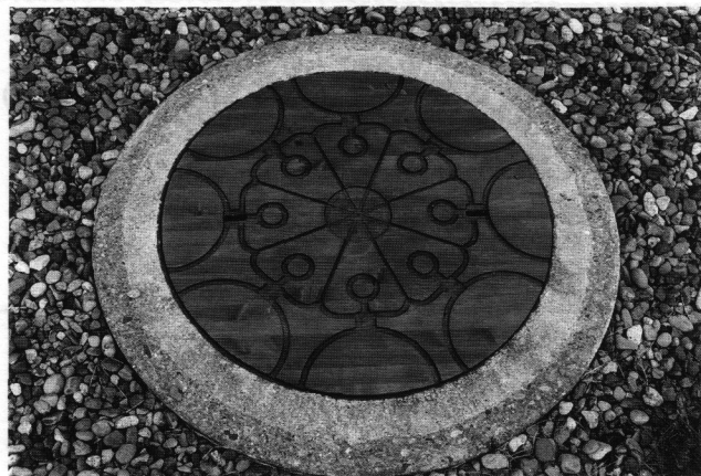
写真6 実証試験中のマンホールふた
