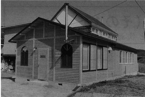
三期工事で完成した現在のおもちゃの家，2階部分が古い工房
