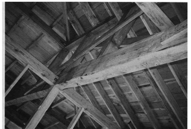
写真6 小屋組と野地板の施工
