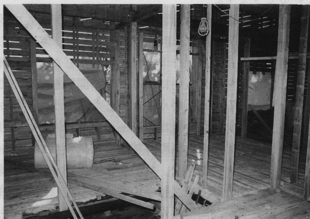
写真2 外壁のモルタル・ラス下地と断熱施工
