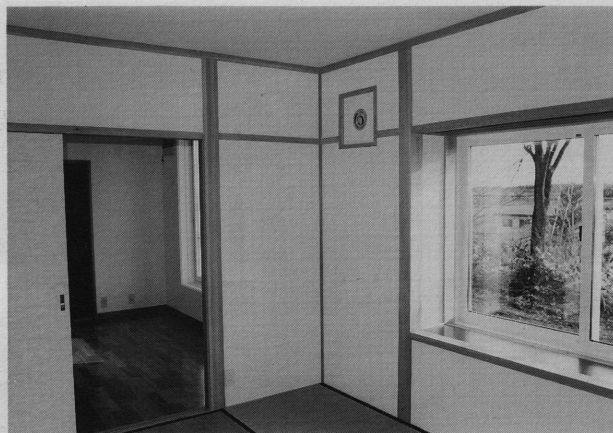
写真3 内装に浮き出る無節カラマツ材
