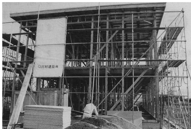
写真9 2階建共同住宅へのカラマツ使用(旭川市)
