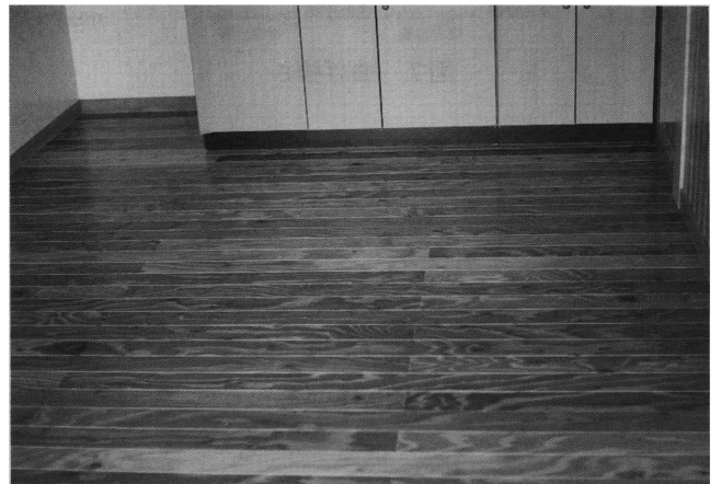
写真5 ロッジのフローリング (フェノール樹脂含浸)
