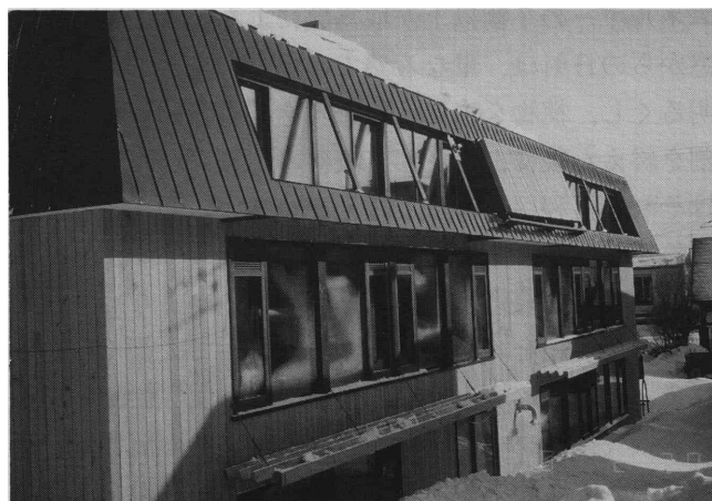
写真1 低負荷建物の外観
