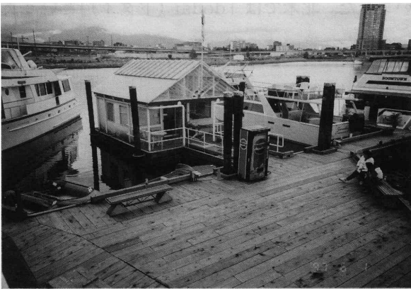
写真8 マリーナで使用されている防腐処理木材 (バンクーバー)
