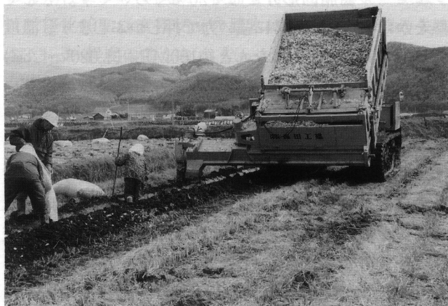
写真 疎水材投入機による暗渠排水施工工事
