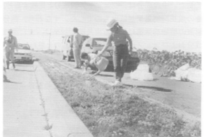
写真4 敷設後の散水の様子
