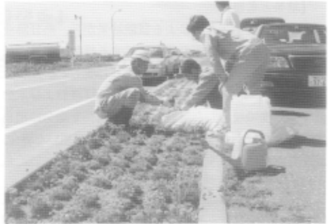
写真3 試験敷設の様子
