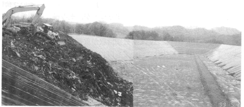
管理型処分場に埋立てされる混合解体材
