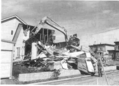
機械解体現場
