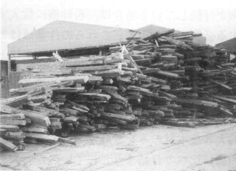
分別解体材（良質な柱・梁）
