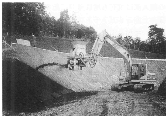
写真2 法面緑化工法の例 専用アタッチメントによる法面への吹付け 出典：製品カタログより転載
