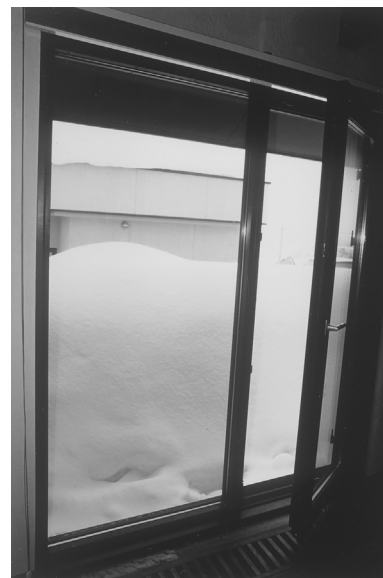
写真3 ドレーキップ窓 （内開きの状態）
