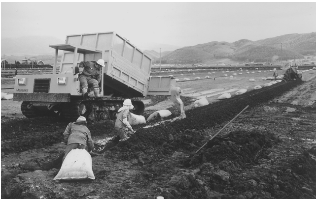
写真2 チップ投入用キャリアダンプによるチップの投入作業
