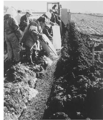
写真1 人力によるカラマツチップの投入作業
