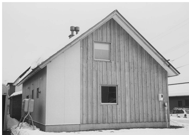
写真1 外壁に対する防火規制により板張りが制限された住宅
