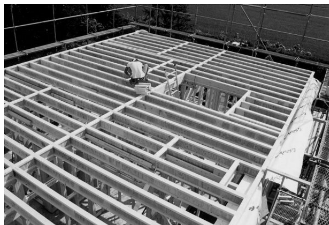
写真4 試験施工の様子(A邸の2階床組)
