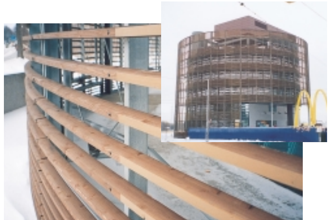
写真2 熱処理材をフェンスとして使用した例(ヘルシンキ市内)
