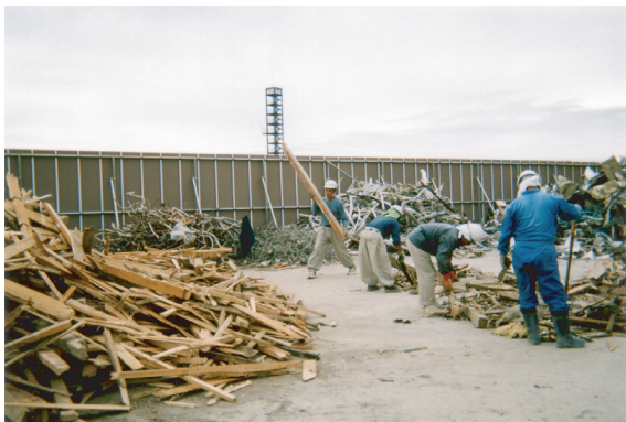
写真2 人手と目視による選別除去作業の様子
