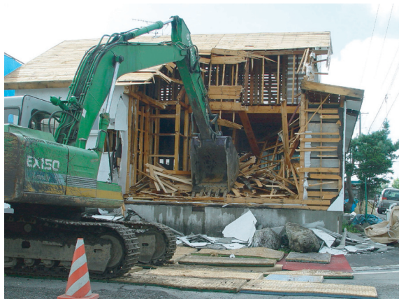
トタン屋根、内装を手解体後、重機で躯体を解体する。
