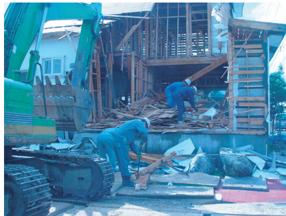
こまめに重機を止めて人手で分別しながら少しずつ解体していく。
