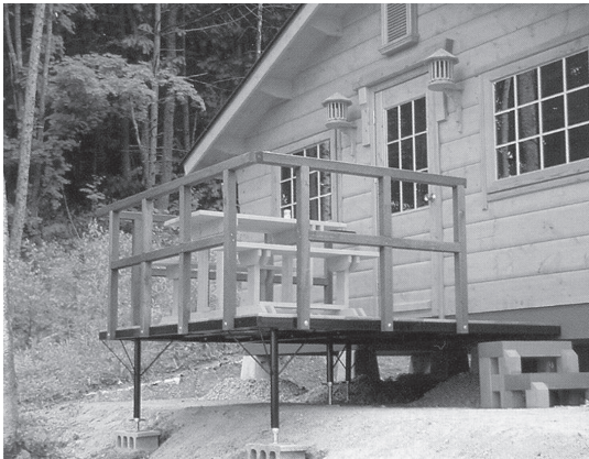
写真4 金属製土台と木とのハイブリッドデッキ
