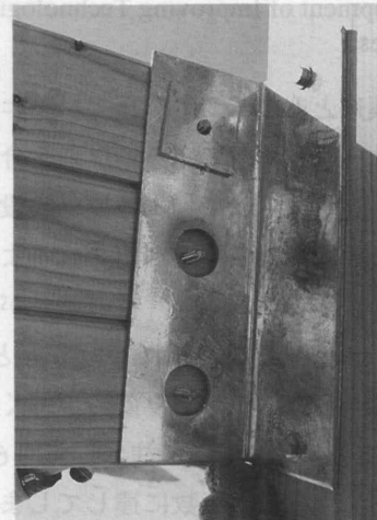
第8図 Bタイプの防風板パネル取り付け部分 Fig.8. Metal fittings which connect windbreak panel with post (typeB).
