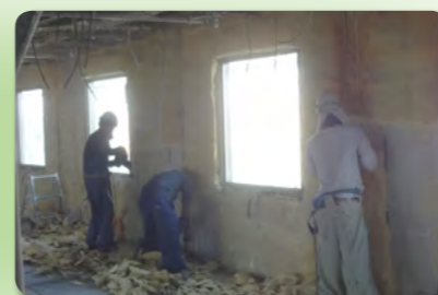
現場発泡ウレタンの剥離作業
