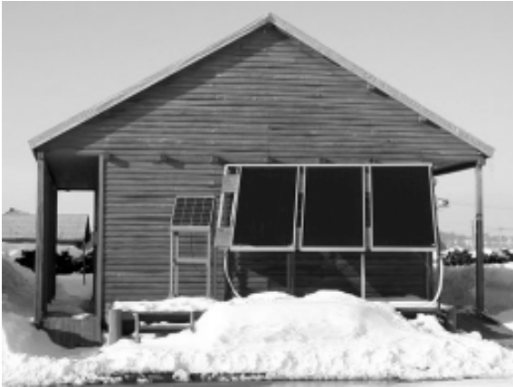
第15図 ソーラーパネルと太陽電池の概観 Fig. 15. Survey of solar collector and solar battery.
