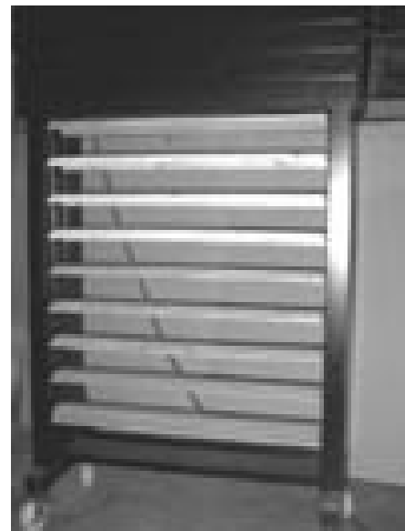
第1図 木製羽根板によるルーバー Fig.1. Louver with wooden fins.
