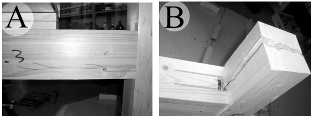
第11図 せん断試験の破壊形態（柱－梁）
