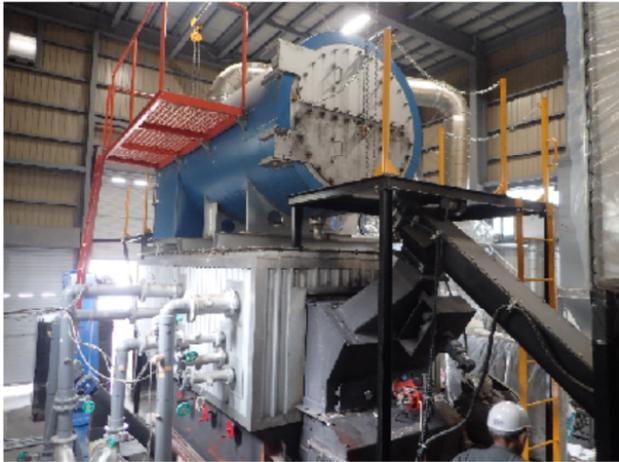
図 4-2-11 燃焼試験に用いた 700kW ボイラ
