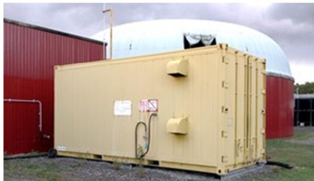
写真 3-1-3-1-3 精製圧縮充填装置
