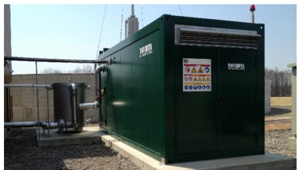
写真 3-1-3-1-2 バイオガス発電機
