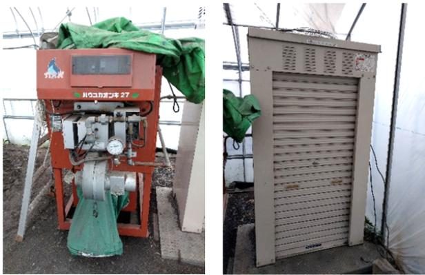
(a) ガスボイラと精製 (b) カードル供給装置
