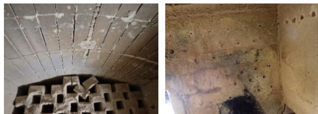
図 3-2-9 仕切り壁, 天井構造, 空気孔
