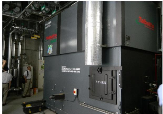
図4-3-3 町内で稼働中のチップボイラ
