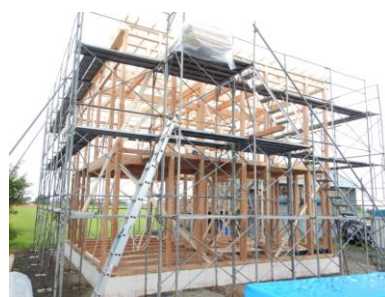
第 1 図 カラマツ心持ち正角材とそれを使用した実証住宅
