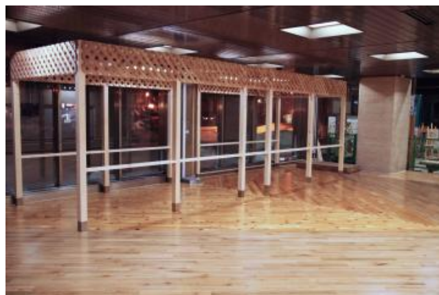
第 2 図 北海道庁ロビーの木質化 (床材の 40%に使用)
