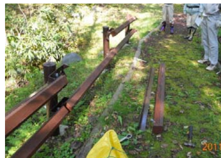
第 3 図 劣化状況調査の様子
