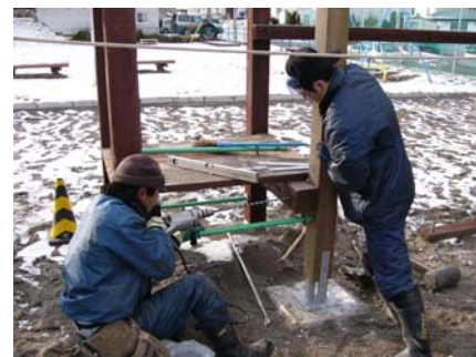
第 3 図 補修金具の施工の様子
