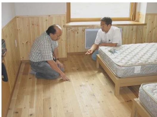
第 1 図 圧縮トドマツフローリングの試験施工
