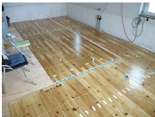
第2図 トドマツ単層フローリングの試験施工
