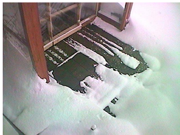
第2図 床下空間配管部の融雪状況例 (融雪路盤を斜め上から撮影)
