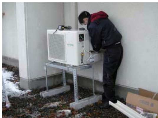
第 1 図 ヒートポンプ式熱源機の設置
