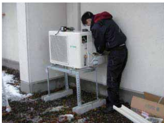
第 1 図 ヒートポンプ式熱源機の設置
