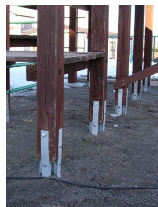
図-9 補修完了の様子
