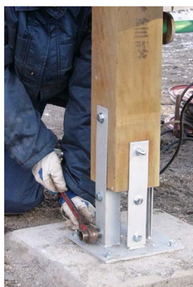
図-8 平金物による固定
