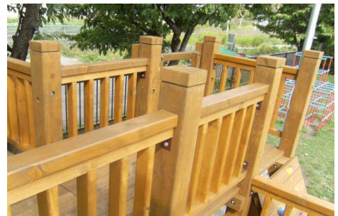
図-4 柱頭木口と手摺の横木を保護
