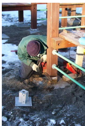
図-6 腐朽部位の除去
