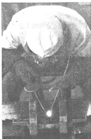
第 3 図 ガス溶接状況
