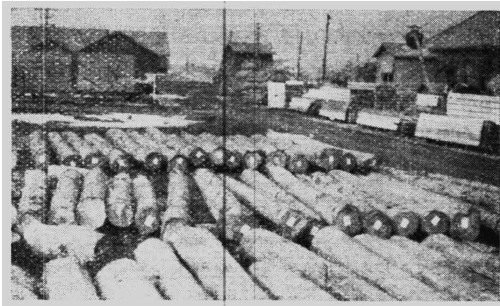
製材試験工場
