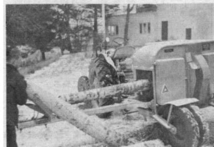
第10図 剥皮された丸太のバーカーからの取出し
