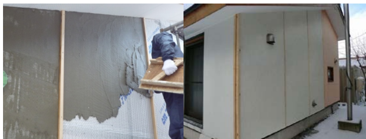
図-5 外装モルタル
