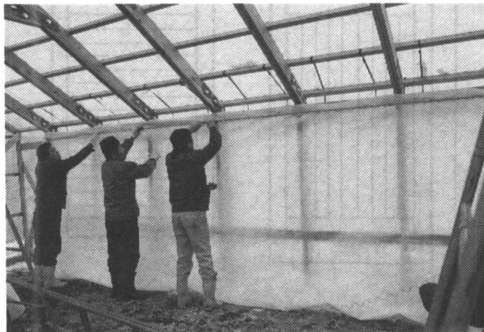
写真15 内装工事 Photo.15 Interior wall and ceiling finish
