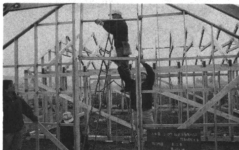
写真12 フレーム・妻パネルの建て上げ Photo.12 Install of framework and gable panel
