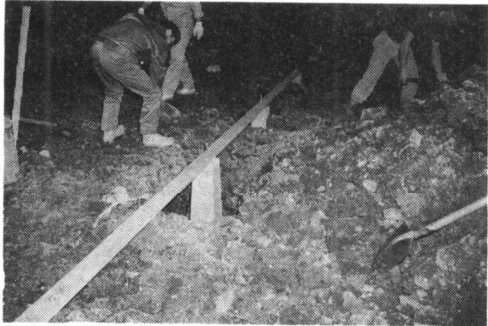
写真9 基礎工事・土台の据え付け Photo.9 Foundation and sill setting works
