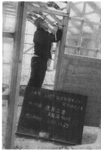
写真14 建具取り付け Photo.14 Install of fittings
