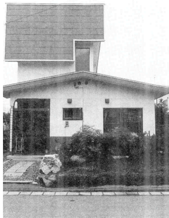
写真 9 調査家屋 [ ケース 3 ] 外観 Photo .9 . The outside appearance of the house surveyed , case 3 .
