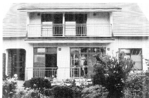
写真 17 調査家屋 [ ケース 6 ] 外観 Photo . 17 . The outside appearance of the house surveyed , case 6 .
