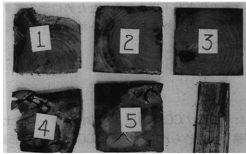
写真43 CCA加压注入土台の腐朽状態(クロマソロールS呈色で濃青色の部分がCCA浸潤部)、番号は図44に示した試片採取位置を示す Photo.43. Decay condition of the CCA-treated sill. Note: "Dark-blue" indicates CCA-treated part. Numbers correspond to the ones in Fig. 44.
