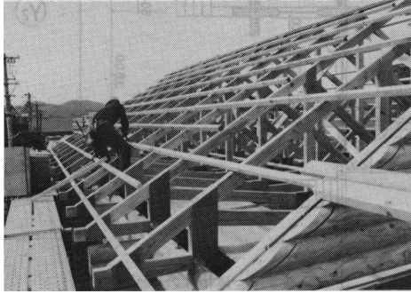
写真3 屋根トラス Photo. 3. Roof trusses on log walls
