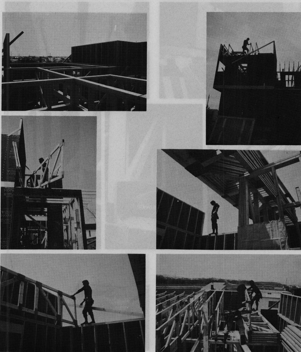
写真12 トラスの施工
