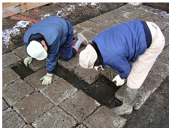
第 2 図 木質系断熱ブロックの敷設
