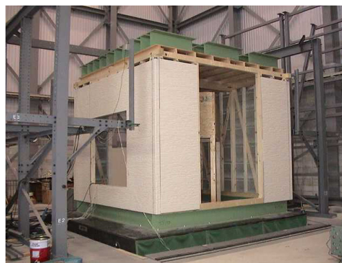
第 3 図 実大躯体の加震実験
