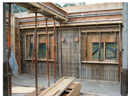
第 3 図 再生合板の実証試験
