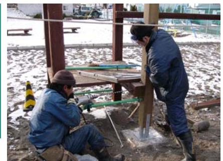
第 3 図 補修金具の施工の様子
