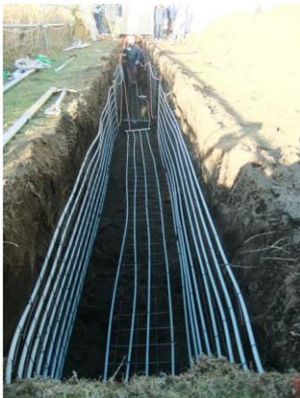
水平採熱式HPシステムの概要
