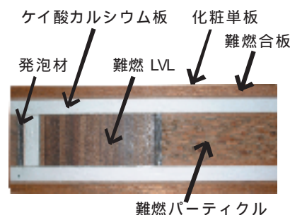
写真 1 防火ドアの構造
