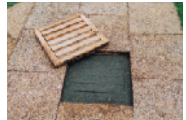
写真 8 カラマツ樹皮と製材を使った舗装ブロック
