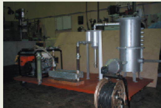
試作したガス発電装置
